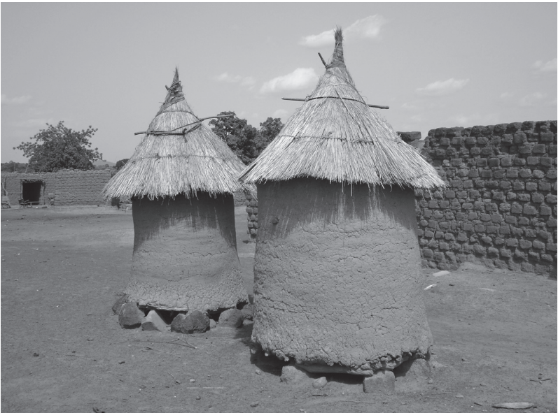
Photo 4.2. Greniers traditionnels en banco pour le stockage des céréales (© J.-F. Cruz).
