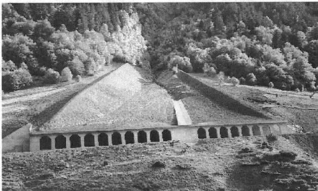
Figure 22. Vue générale de l'ouvrage.
