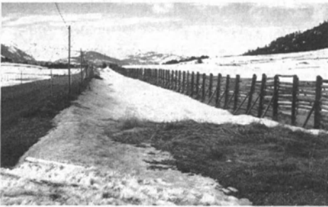
Figure 36. Barrière à neige placée trop près de la chaussée (photo B. Constantin/Cemagref).
