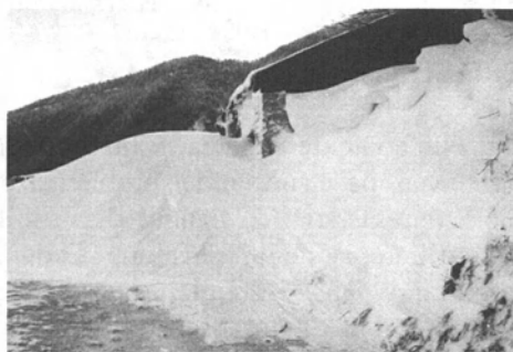
Figure 7. Congère générée par un bâtiment (photo F. Ousset/Cemagref).
