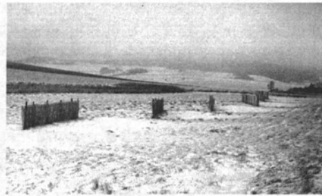
Figure 37. Barrières à neige disposées avec une longueur de recouvrement insuffisante (photo G. Brugnot/Cemagref).
