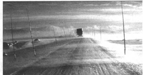
Figure 46. Relèvement du niveau de la chaussée en Norvège : on remarque l'absence de formation de congères sur la chaussée lors d'un épisode de transport de neige (photo H. Norem/NGI).
