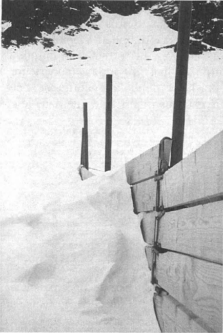
Figure 28. Congère générée par une barrière pleine sans garde au sol (photo F. Naaim/Cemagref).
