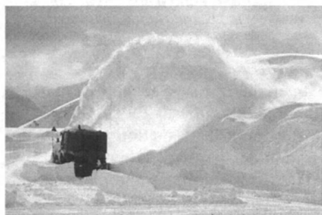
Figure 6. Déneigement d'une route de montagne (photo C. Charlier/Cemagref).
