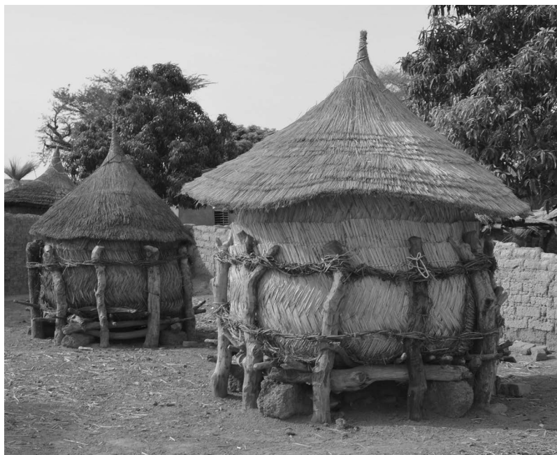
Photo 4.1. Greniers en fibres végétales au Burkina Faso (© Thierry Ferré, Cirad).
