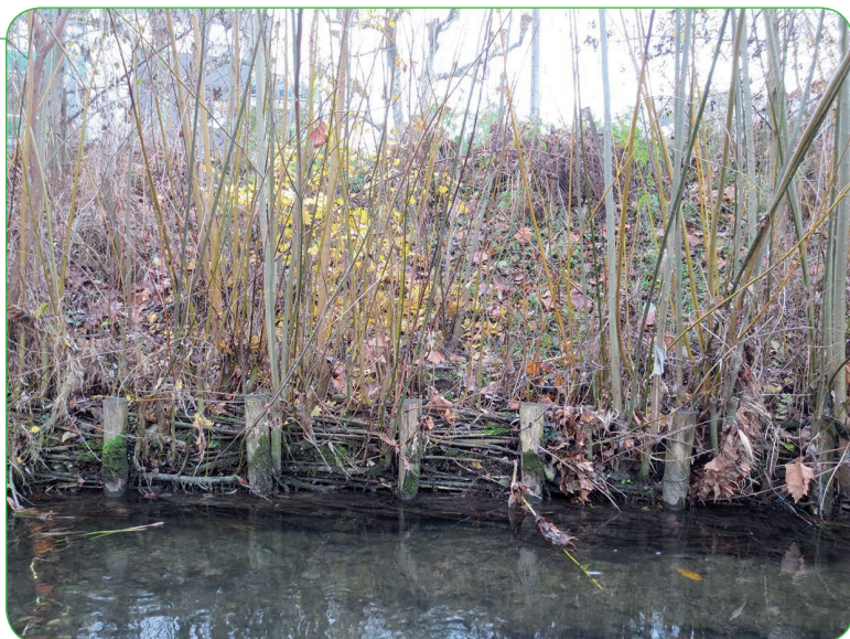
Figure 4. Ouvrages de génie végétal en milieu aquatique.
