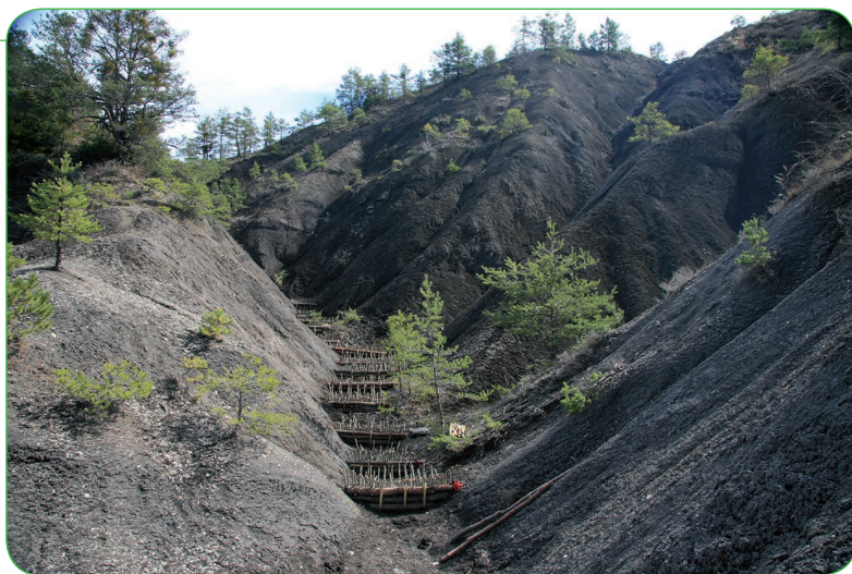
Figure 2.6. Ouvrages de génie végétal sur une ravine.
