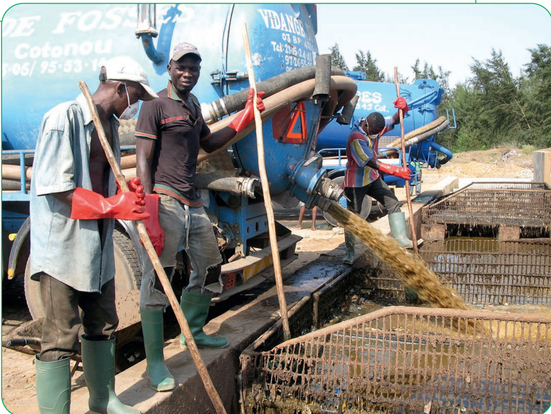
Photo 11.2. Vidange des camions vide-fosses à l'entrée de la station d'épuration des eaux usées de Sèmè-Podji, Bénin © Akiça Bahri.
