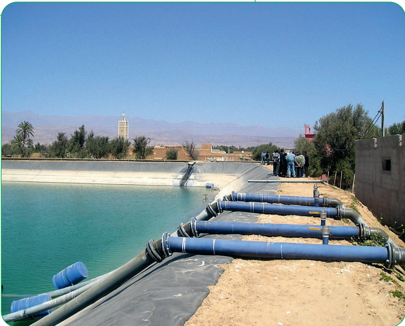
Photo 4.2. Réservoir et système de distribution d'une grande ferme de la région du Souss, Maroc © LISODE.
