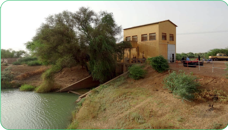
Photo 8.1. Station de pompage dans le périmètre irrigué de Podor, SAED, Sénégal © Jean-Yves Jamin, Cirad.
