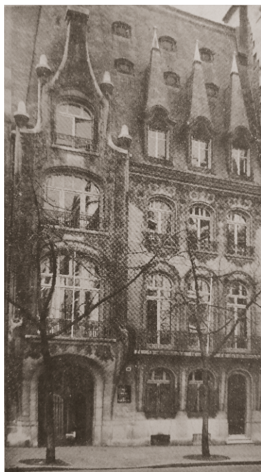
■ Immeuble occupé par l'OSTPM puis par l'ISTPM, de 1943 à 1969, au 59 avenue Raymond-Poincaré, Paris 16 e , vers 1944.
