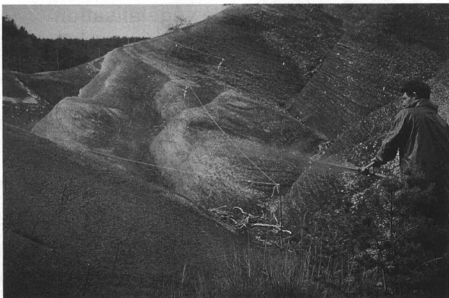
Mise en place de la végétalisation par semis hydraulique (14/4/1993)
