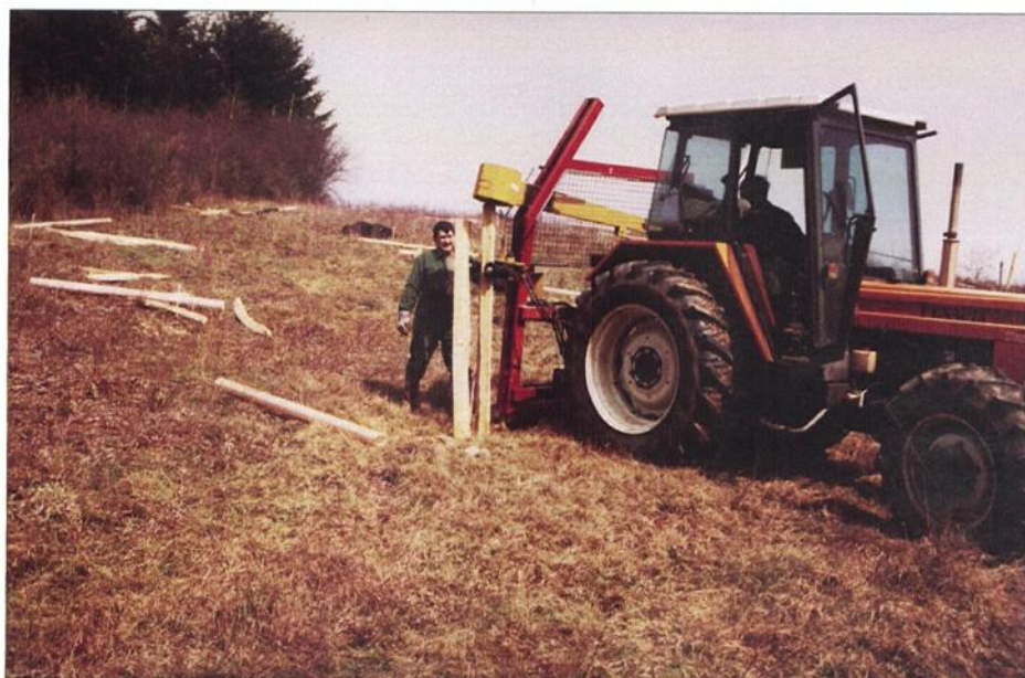
Figure 14 : Mise en place des pieux (photo G. Agrech).
